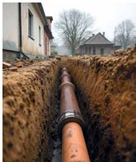
Praxisbeispiel einer Verbindung von einem Steinzeugrohr auf ein KG-Rohr mittels einem Crassus Schlauchadapter Typ 2B und Ausgleichsringen
