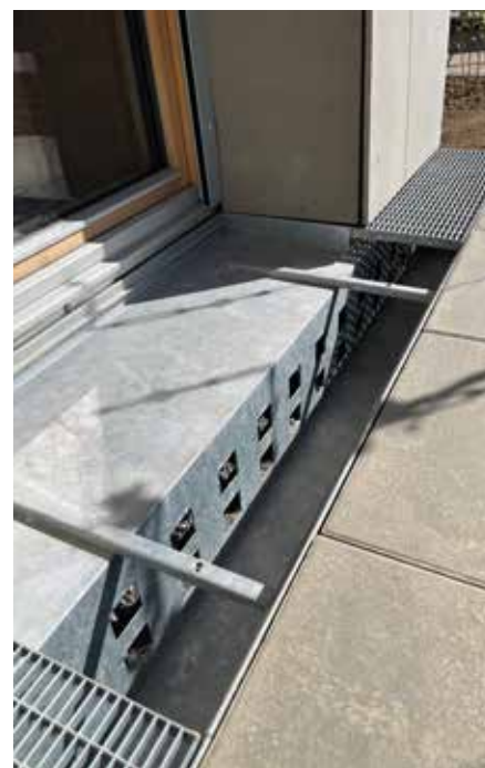
ACO ino 606.1 – Einbau an der Holzfassade
