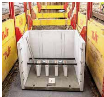
Werkseitig montierte Betonsockel dienen als Pumpenfundamente
