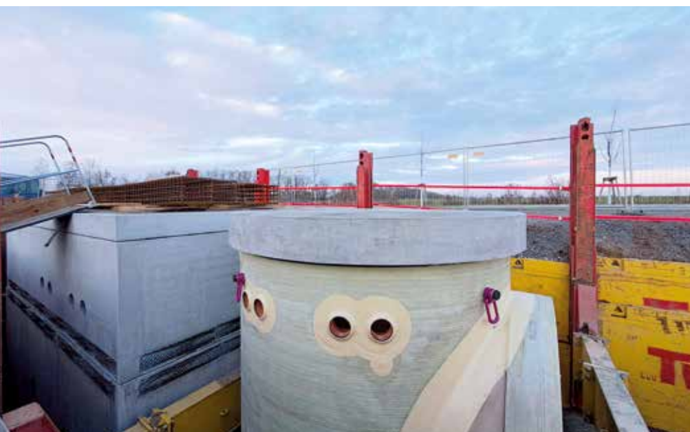
Das individuell hergestellte Pumpwerk bietet Platz für vier leistungsstarke Pumpen
