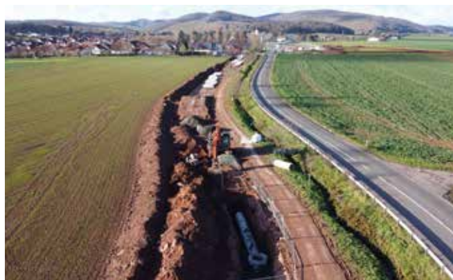
Der Regenwasserkanal wird aus dem Neubaugebiet entlang der Straße in ein Regenrückhaltebecken geführt (Foto: FINGER BAUSTOFFE GMBH)
