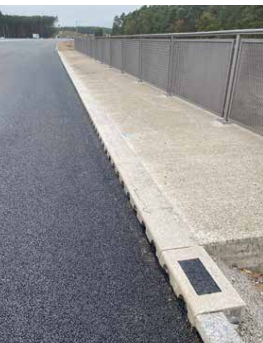
Kombination aus Entwässerung und Schrammbord schafft mehr Platz für die Fahrbahn
