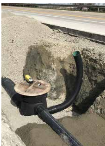
MULTI- inspect DUO mit seitlichem Anschluss für den Straßenablauf
