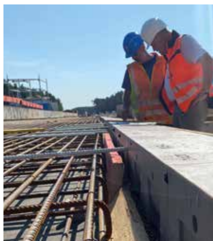
Glasfaser-Verbundstoff-Stäbe zur Verankerung der Hohlbordrinne in der Brückenkappe
