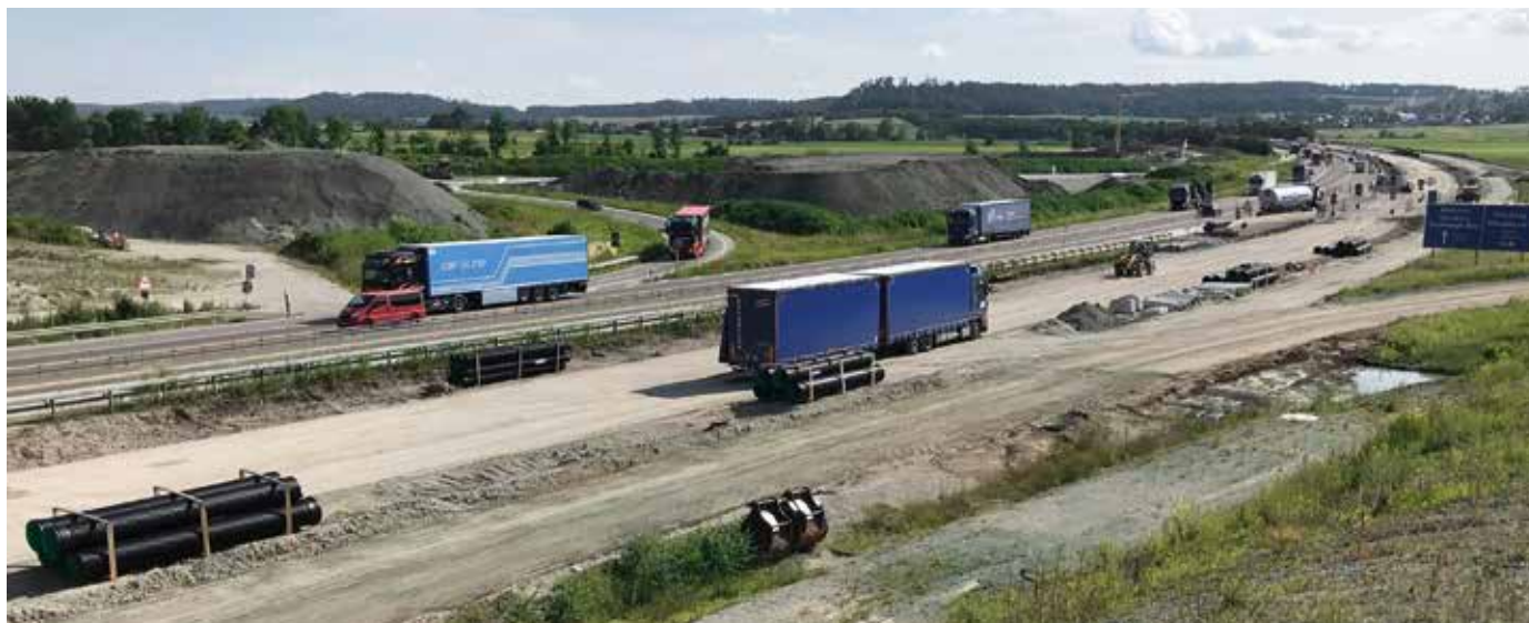
Vorbereitung des Entwässerungssystems aus PE-HD für den Einbau
