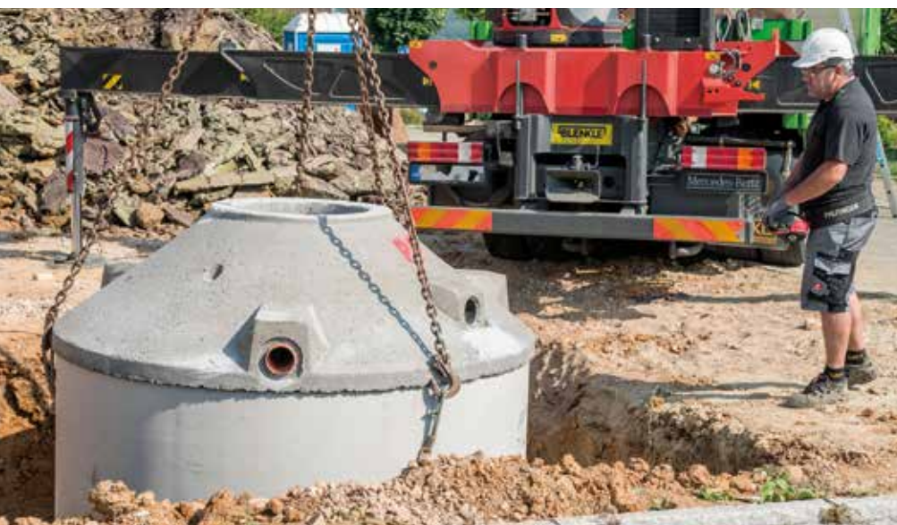
Verladung der ausgestatteten Zisterne direkt in die Baugrube (Bildquelle: Mall GmbH)
