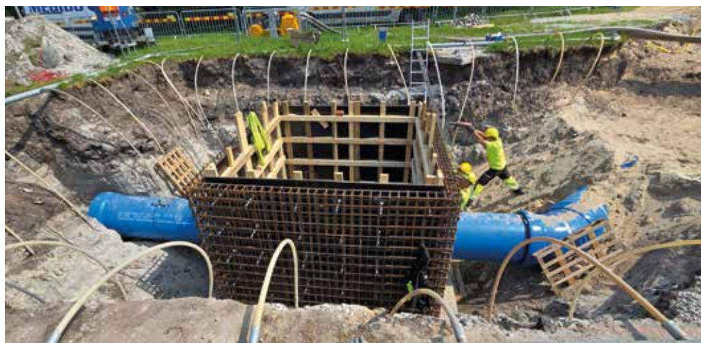
Schieberschacht mit Absperrrklappe DN 800, Pass- und Ausbaustück und T-Stück DN 800/200
