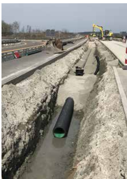
Huckepackanordnung mit AQUATUB-Rw und AQUADRAIN Rohrsystemen
