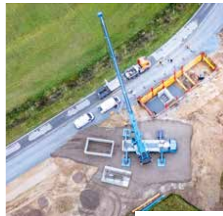
Die Montage von Betonfertigteilen sorgt für raschen Baufortschritt
